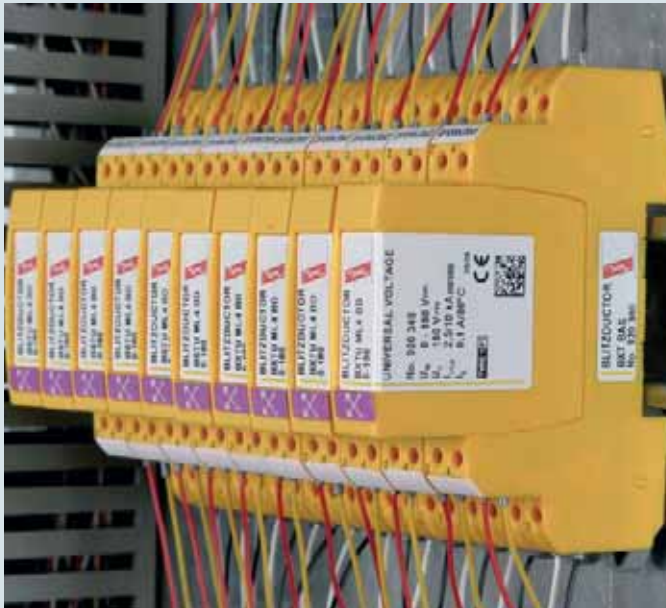
BLITZDUCTOR XTU completamente montado.
