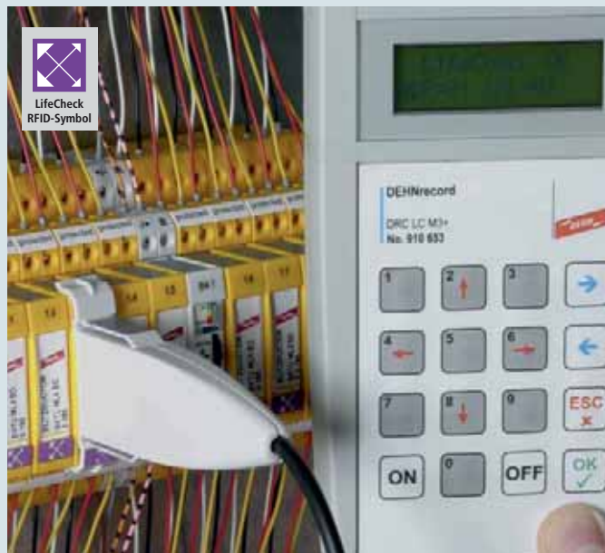
Comprobación de un módulo de descarga con tecnología RFID (LifeCheck)
