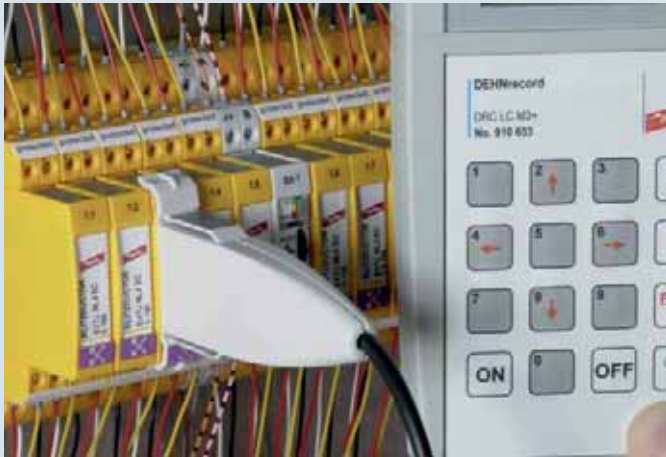
Verificación de un módulo de descargador con técnica RFID (LifeCheck)
