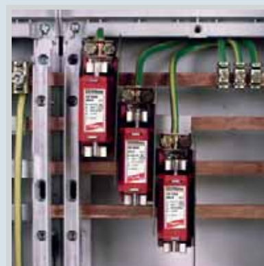
DB NH00 255 H instalación en barra colectora de un DB NH 00.
