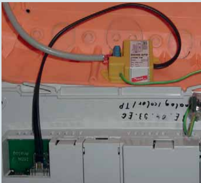
Descargador de sobretensiones para montaje bajo pared en interfaces LAN
