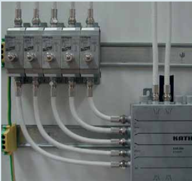
Descargador de corriente de rayo/sobretensiones como adaptador de cable para sistemas coaxiales de telefonía móvil e instalaciones de antenas.
