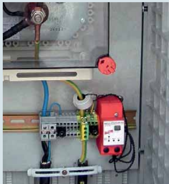
Contador con alimentación de batería incorporado (9 V) y control de la situación de carga. Indicación a través de LCD de dos dígitos con teclas de ajuste y de reposición.
