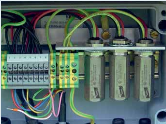
Descargador de sobretensiones para zonas exteriores atornillables a los equipos de campo. Ejecución en acero inoxidable hasta IP 67.
