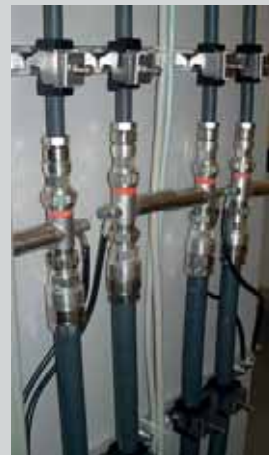
Aplicación de descargadores Lambda/4
