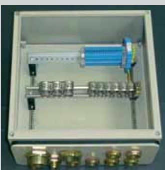
Aplicación de la vía de anclaje
