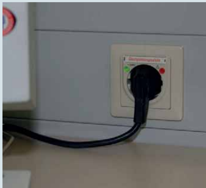
Protección de aparatos electrónicos contra sobretensiones. Caja de enchufes con circuito de protección contra sobretensiones.
